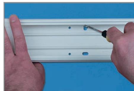
Наличие перфорации на дне короба существенно облегчает его монтаж к стене
