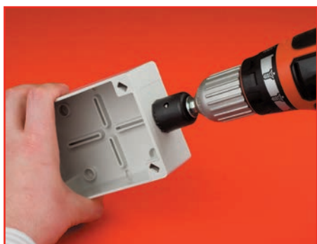
Сверлим отверстия необходимого диаметра
