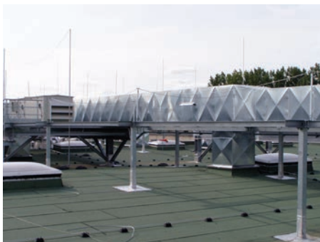
Система отдельностоящих мачт, защищающая воздуховоды системы кондиционирования
