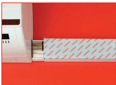
Закройте смонтированную трассу крышкой
