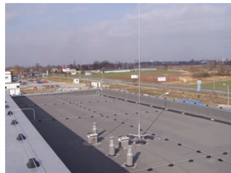
Совместное использование молниеприемной мачты и сетки
