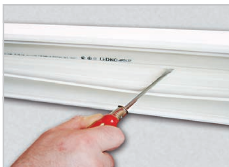
Для снятия разделителя с короба воспользуйтесь плоской отверткой, вставив ее в специальный желоб
