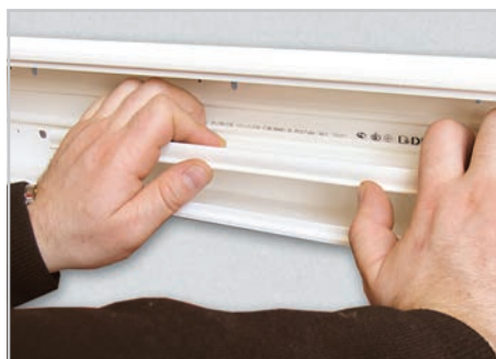
Разделитель защелкиванием устанавливается на направляющие дна короба
