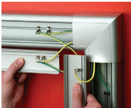
Количество монтируемых проводов заземления в плоском углу
