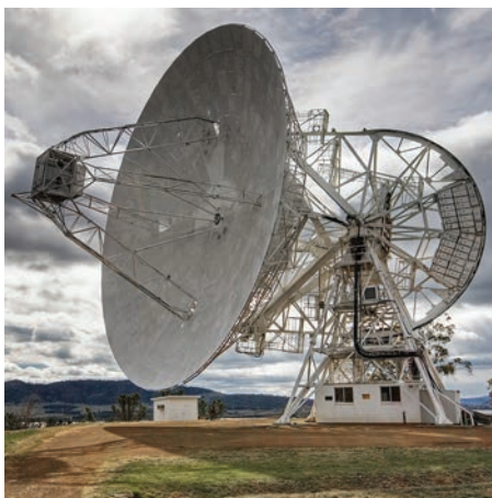
Системы управления и телекоммуникации
